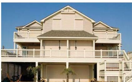
**Figura 4-10.** Persiana sanfonada (mostrada na posição aberta) instalada sobre uma grande janela de uma casa costeira. A persiana foi instalada para permitir a implantação de dentro de casa. Imagem cortesia de Roll-a-way.
