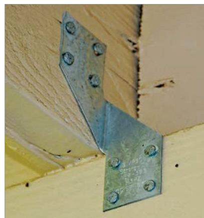
para o sistema horizontal de piso ou telhado, utilizando a resistência ao cisalhamento no piso ou telhado para resistir à carga de vento aplicada. Isso agora é necessário em novas construções perto de um campo aberto ou na água com poucas outras estruturas ou árvores que quebrem o vento.
