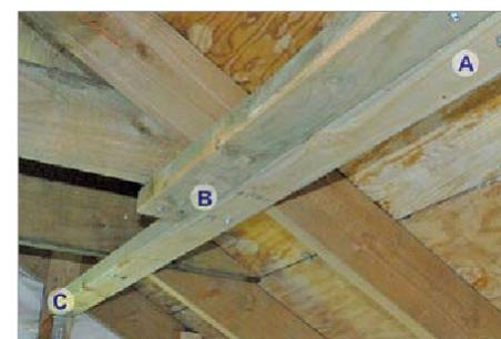
**Figura 4-3.** Nesta aplicação de contraventamento lateral, os 2x4 estão a 18 polegadas da cumeeira e se conectam aos membros horizontais que fixam as treliças opostas. Nem todos os telhados tem membros horizontais. Os 2x4s estão conectados com dois parafusos #14 de 3 polegadas (A) e superpostos em duas treliças (A e B). A extremidade é conectada à extremidade do frontão com um ângulo ou suporte em L (C). Imagem cortesia de Dennis Hwang.
